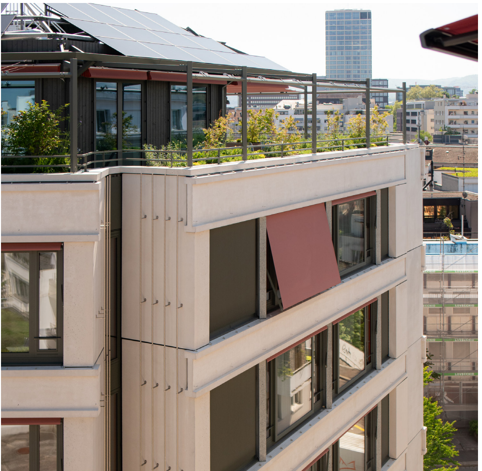
Blick auf die Dachterrasse, Haus irides
